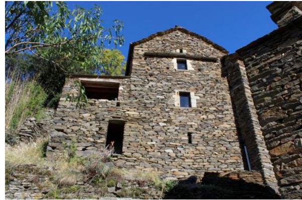
Faîtage en parpaillou aux Alègres Pierres en saillie de la façade à Nojaret
