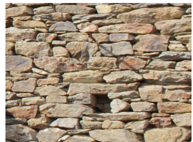
Détail d'un mur de schiste aux Alègres
