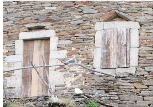
Ouvertures au village de Bonnevaux : encadrements en grès et types différents d'arcs de décharges
