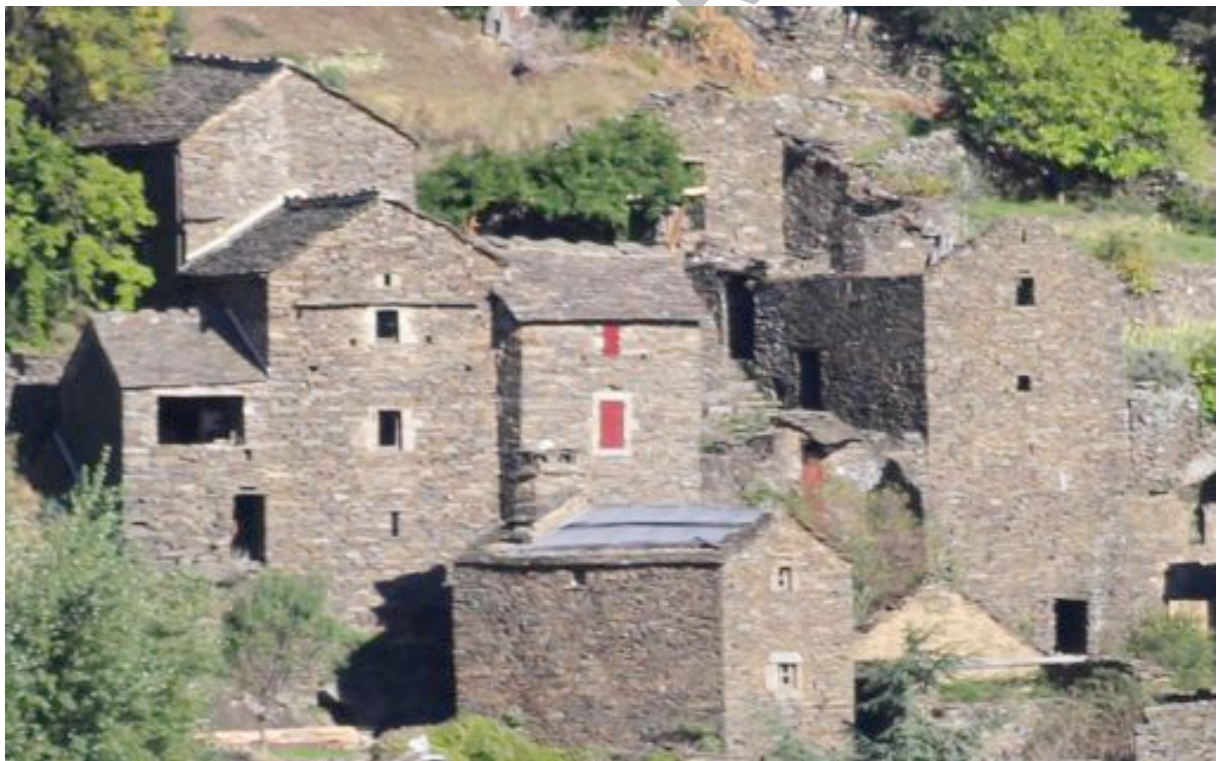
Vue sur Nojaret : constructions caractéristiques du territoire dans la forme, les proportions et les ouvertures (on remarquera un ajout moderne sur la gauche, identifiable aux proportions de son ouverture)
